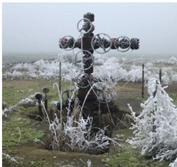
6. ábra. A Nagyszénás-3. kút kútfejszerelvénye a karácsonyfával
