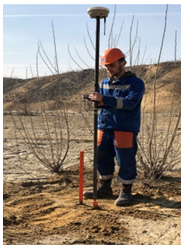
3., 4. ábra. Hányóvizsgálati monitoringpont bemérése GPS-vevővel
