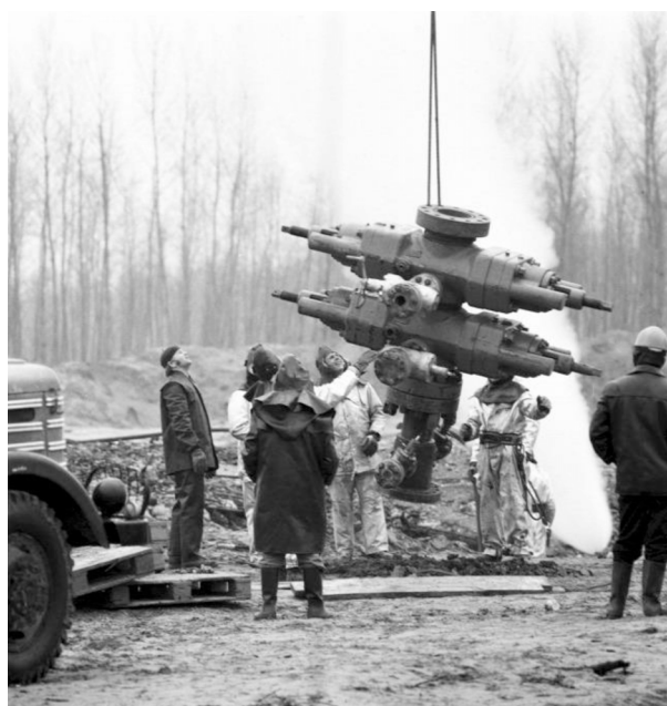
13. kép. A kitörésgátló beemelése és csatlakoztatása a bélésűcsőfejhez
