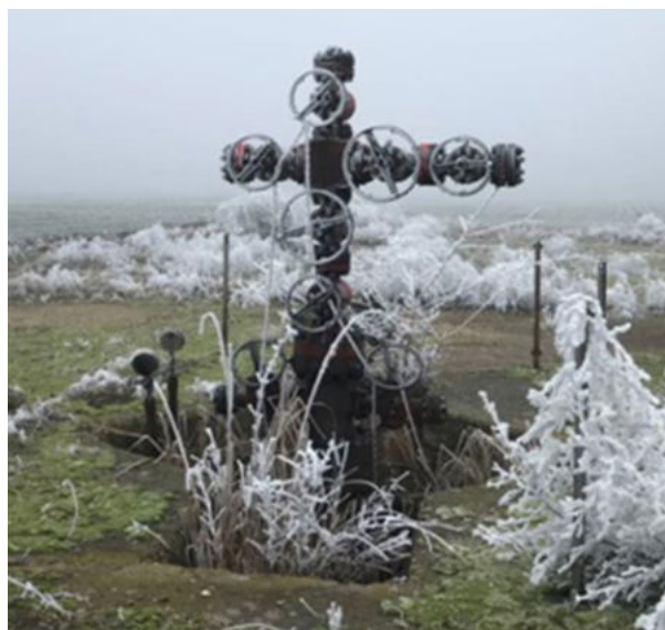
6. ábra. A Nagyszénás-3. kút kútfejszerelvénye a karácsonyfával
