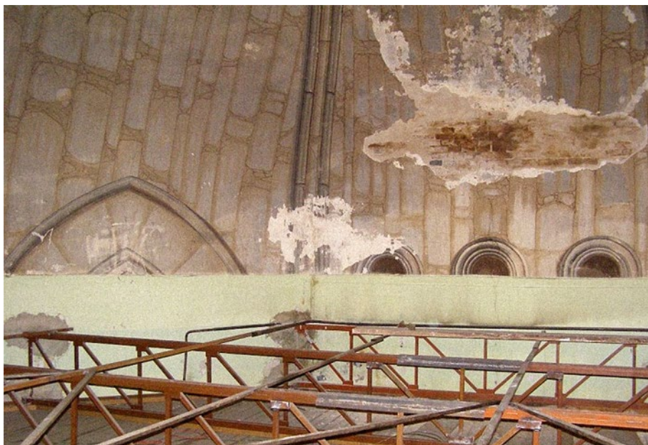
5. kép: A kápolna helyreállításának megkezdése 5
