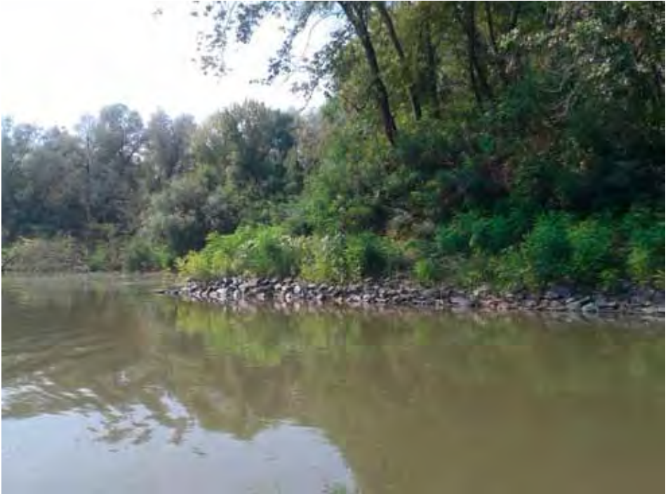
5. kép Partbiztosítás a csanyteleki kanyarulat ÉK-i részén (Fotó: Kis É.) Picture 5 Bank enforcement in the NE of the Csanytelek meander (Photo by Kis, É.)
