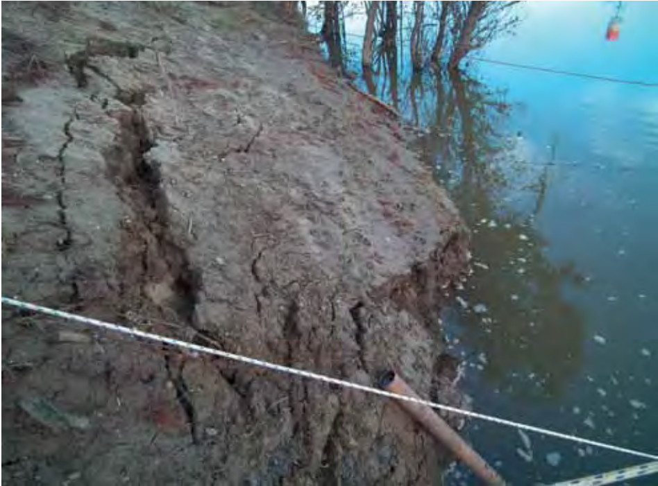
3. kép Közvetlen csuszamlás előtti időszak kinyíló karéjos repedésekkel és a kőzetrepedésekből kihabzó vízzel (Fotó: KIS MOLNÁR, I.)
