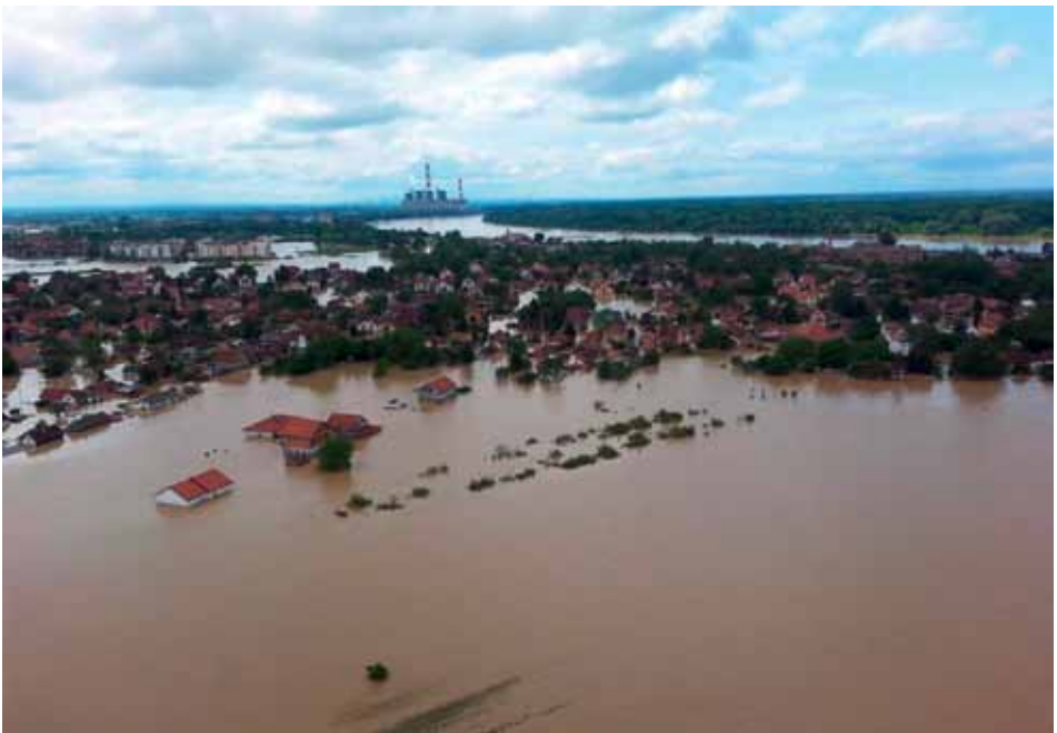
2. kép Az elöntött Obrenovac 2014 május 18-án. Háttérben a Száva és a Nikola Tesla hőerőmű (Fotó: Szerb Rendőrség) Photo 2 The flooded town of Obrenovac in 18 May of 2014 with the Nikola Tesla Power Plant in the background (photo by Serbian Police)
