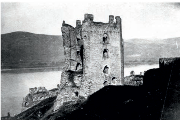
2. ábra. V alakú sérülés a Salamon-torony déli sarkában, az I. Ferdinánd csapatai által vezetett várostrom eredménye. Az 1540. október 12-én bekövetkezett omlás feltárta a lakótoronyt mind a hat emeletét. A szemlélővel szembenéző, keleti oldalon az ablakok vonalában végigfutó, függőleges repedés látható – ez erős földrengés nyoma, mely az ostrom okozta sérülésektől függetlenül keletkezett. BESZÉDES Sándor felvétele 1870-ben (Forster Központ Fotótára 52495N) (Bozóki 2014, 2. ábra)
