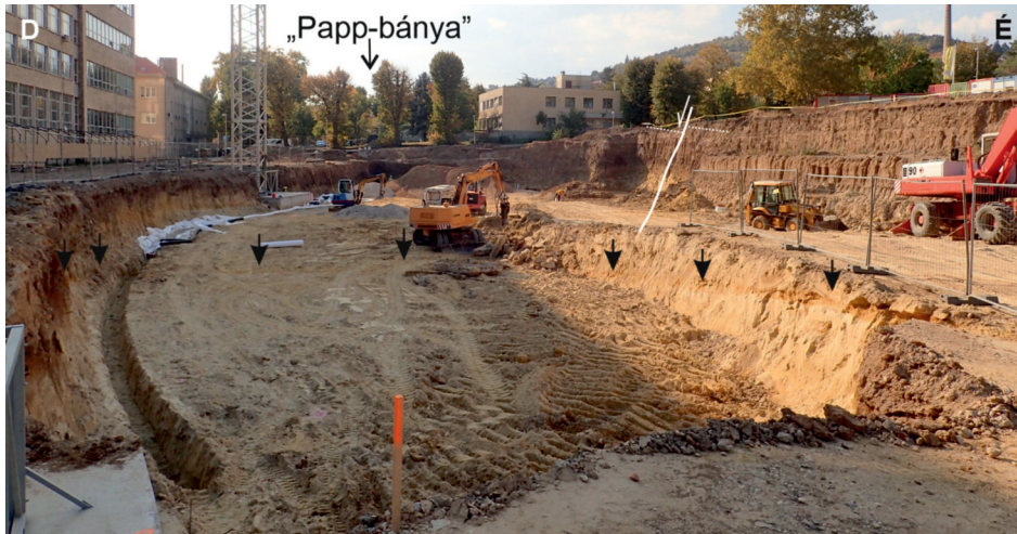
7. ábra. A PTE orvosi kar új épületének alapozása 2018 októberében. A nyílak egy réteg lefutását jelölik.
