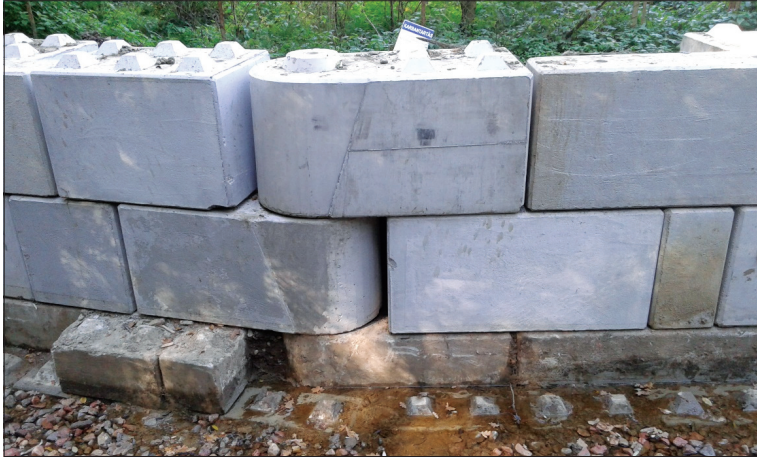
2. ábra. Iránytörés kiépítése (Forrás: PATCO 95 Bt.)
