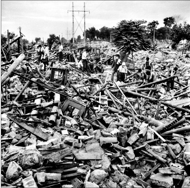
3. kép. A Tangshan-i földrengés hatása 16
