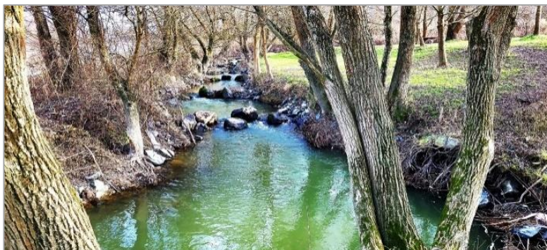
3. kép. Dunaszigetnél a Denkpáli ágvéglezárásba beépített természet közeli halátjáró (Fotó: Kertész) Photo 3. A back-to-nature fish ladder built at the Denkpáli branch end closure at Dunasziget (Photo: Kertész)
