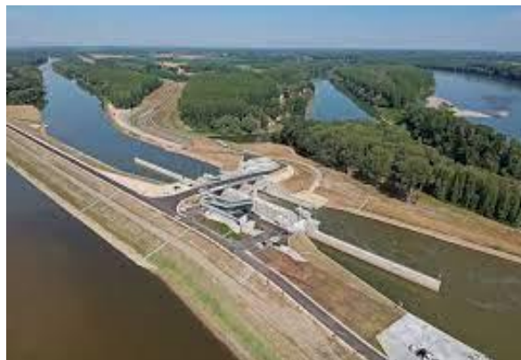
7. kép. A Mosoni-Duna torkolati műtárgy (Fotó: ÉDUVIZIG) Photo 7. The Mosoni-Danube estuary unit (Photo by ÉDUVIZIG)
