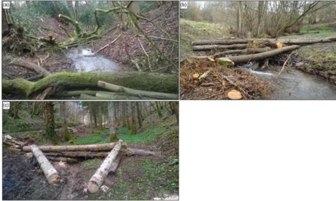
2. ábra. Rönkgátak a Frome vízgyűjtőjén, Anglia. a) természetes, b) fél-természetes, c) strukturált gátszerkezet (Short és társai 2018)
