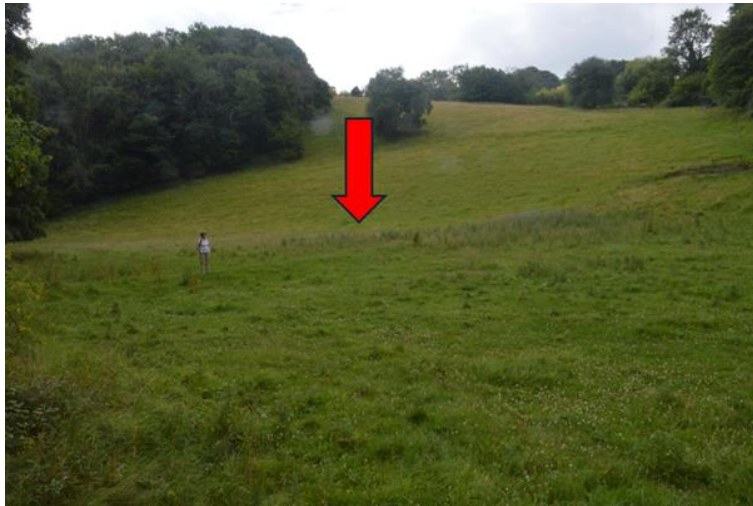
7. ábra. Vízz visszatartó földhány (az ábra közepén, piros nyíllal jelölve) a Frome vízgyűjtőjén, Anglia (Fotó: Halupka 2022) Figure 7. Water retention earth bank ('earth bund', marked with red arrow) in the Frome catchment, England (Photo by Halupka 2022)
