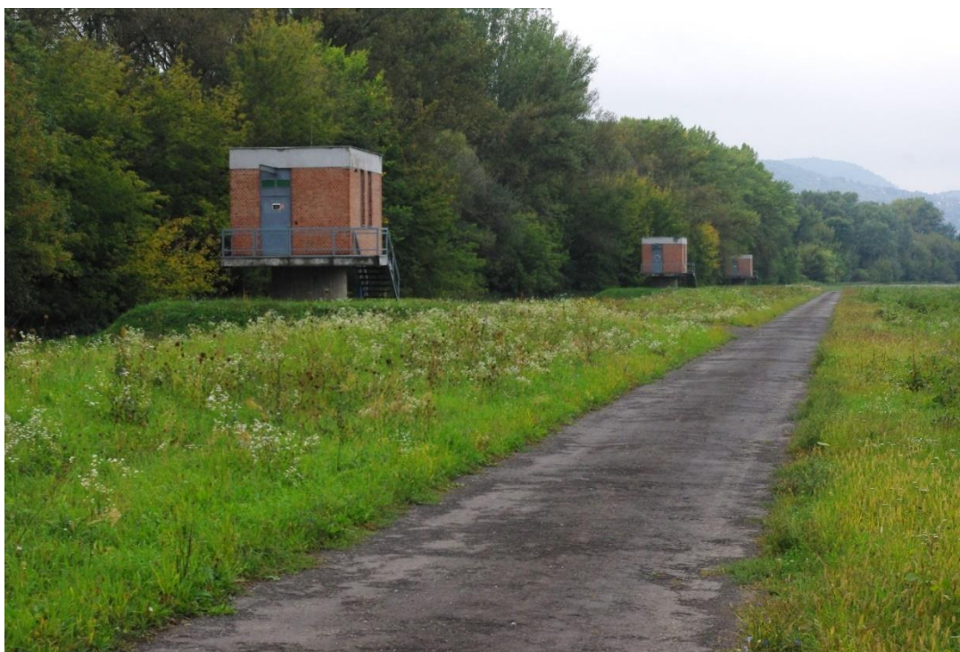
A Szentendrei-szigeten lévő két csápos kút sor (Fotó: Nyiri Gábor) A series of radial wells on Szentendre Island (Photo: Gábor Nyiri)
