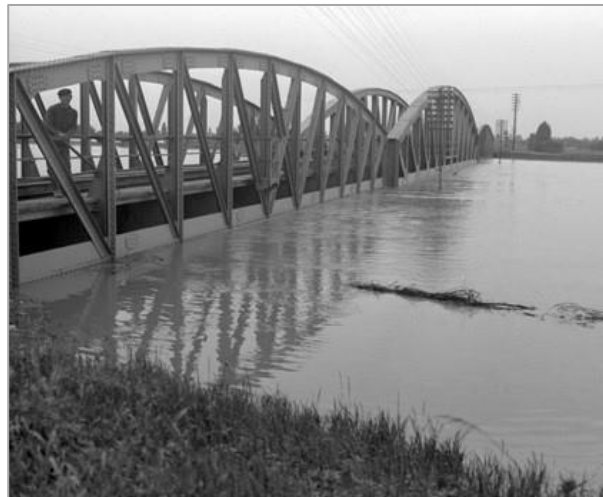
2. kép. Árad a Fehér-Körös, a gyulai híd alsó övlemezei már félig vízben állnak (Szlávik 1976a)
