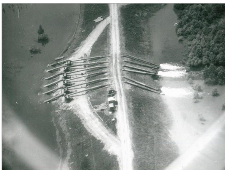
7. kép. A Fehér-Körös jobb parti töltésén telepített szivattyú provizóriumok (KÖVIZIG archívum)
