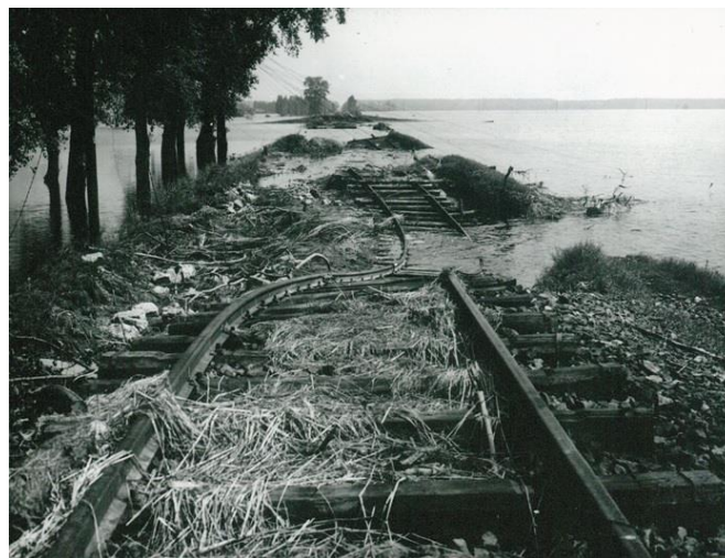
4. kép. Az árvíz pusztítása a deltában: tönkrement a Gyula-Sarkad közötti vasútvonal egy szakasza (Szlávik 1976a) Photo 4. The destruction of the flood in the delta: the destroyed railway line between Gyula and Sarkad (Szlávik 1976a)
