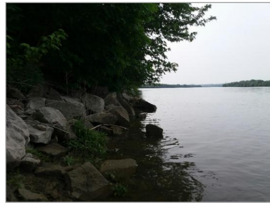
2. fotó. A partvédelmi kőszórás a Gudmon-foki kútsor előtt (Csiszár 2019)
