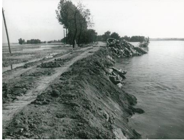
6. kép. A közúti átvágás ideiglenes helyreállítása (KÖVIZIG archívum)
