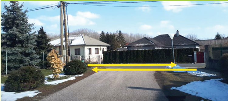
4. ábra: A tervezett gyalog- és kerékpárúton közlekedő kerékpárosokat nem lehet időben észlelni az alárendelt irányból a közeli növényzet, villanyoszlop (bal oldal) és főleg a kerítések (jobb oldal) miatt
