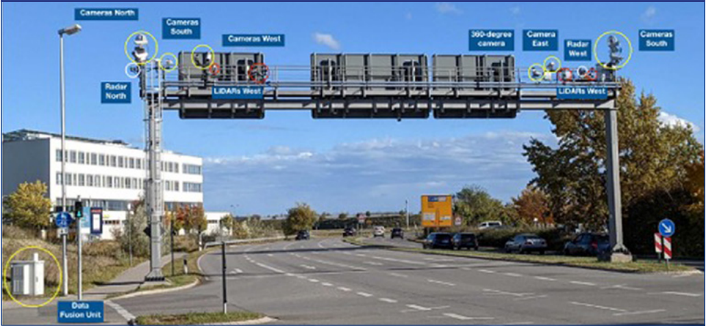
1. ábra: A Providentia++ projektben [2] alkalmazott tartószerkezet és a rá telepített infrastruktúra szenzorok
