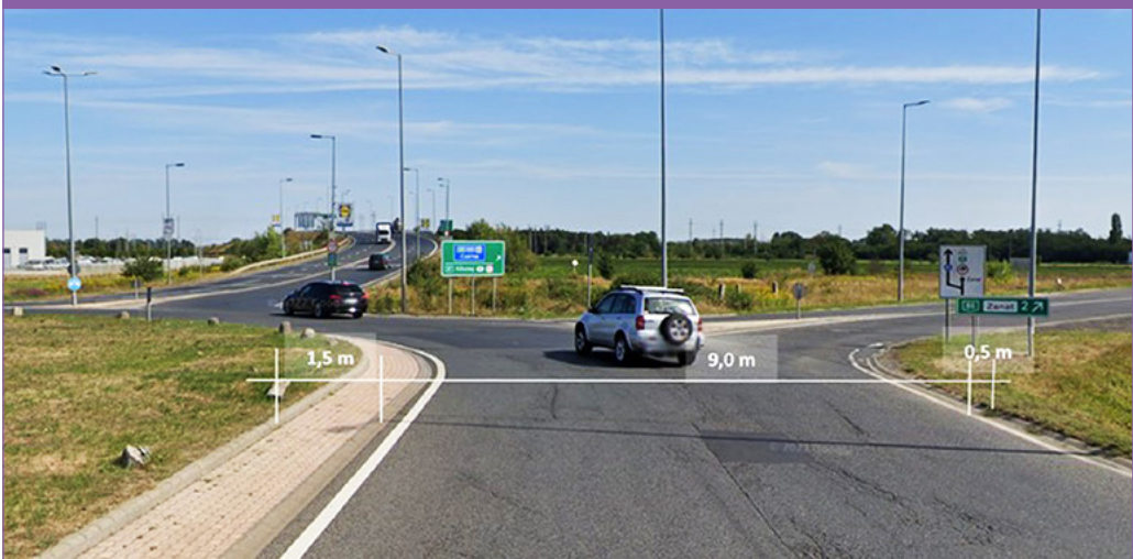
9. ábra: A körpálya keresztmetszeti kialakítása
