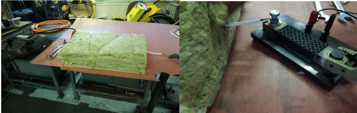
2. Kép: PVC szigetelésű három eres kábel kőzetgyapotban elvezetve gégecsőben
