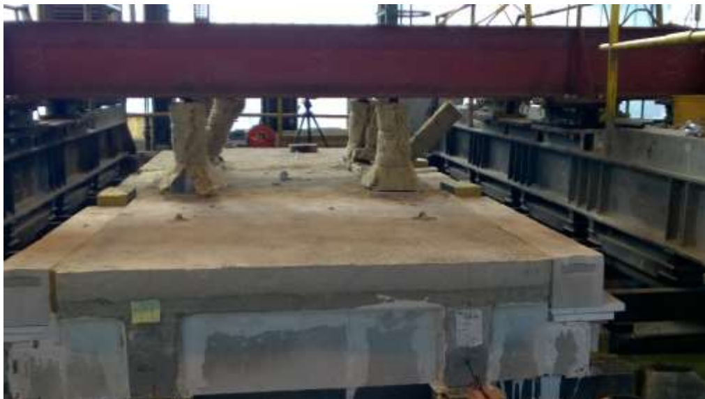
3. ábra: TT panel a beépítés után (fotó Szentendre ÉMI)
