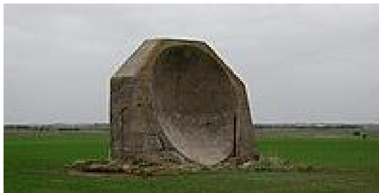
6. kép Betonlokátor Angliában, az I. világháború idején (a közeledő léghajók hangjának észlelésére). Forrás: [20].
