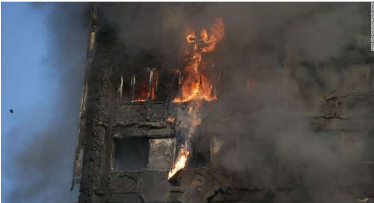
4. kép: A londoni Grenfell Tower égése. A homlokzaton elszenesedett poliuretán hőszigetelés látható 2
