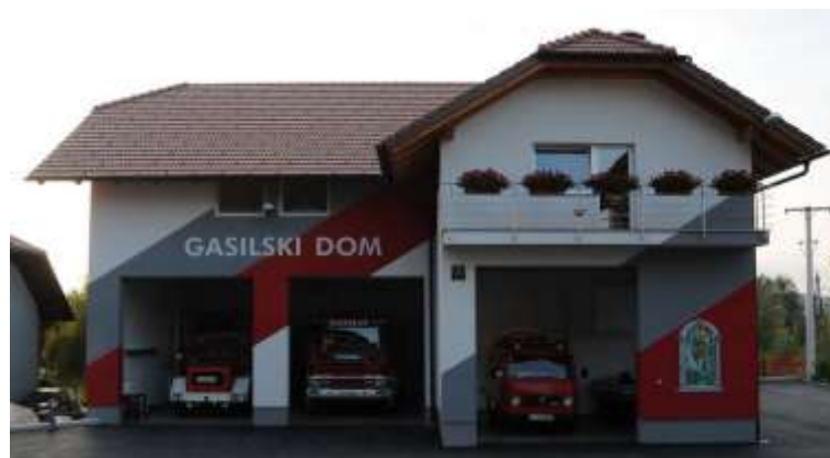
6.sz. kép: Podpeč község tűzoltó szertára (Forrás: [12])
