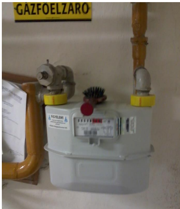
2. kép Az elzárás fogantyú hiányában nehézkes lehet (forrás: szerző saját felvétele)
