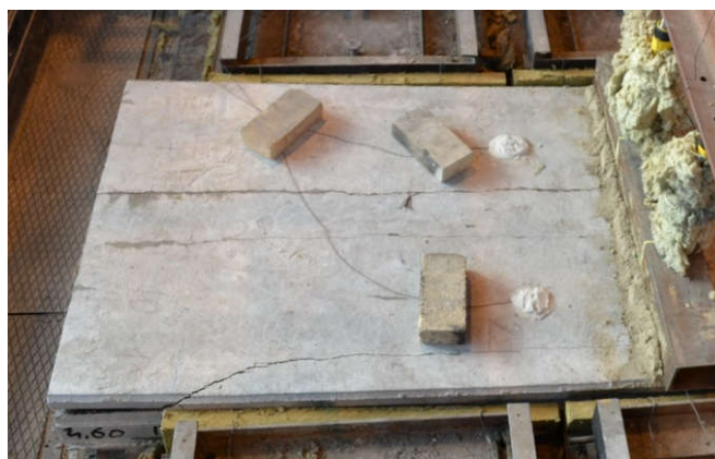
5. ábra: A körüreges födempallón megjelenő hosszirányú repedések és pászma behúzódás (2017. 12. 07.)
