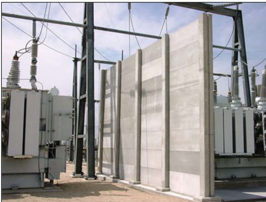
6. ábra: Transzformátor tűzfal [15]
