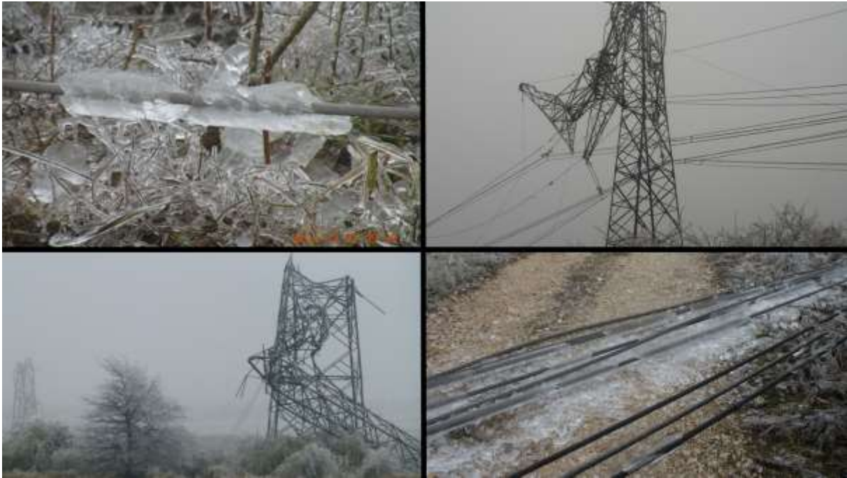
11. ábra. Az ónos eső okozta jéglerakódás, illetve a helyenként 6 tonna plusz teher alatt összeroskadt tartóoszlopok Gödöllő térségében. (MAVIR felvételei).
