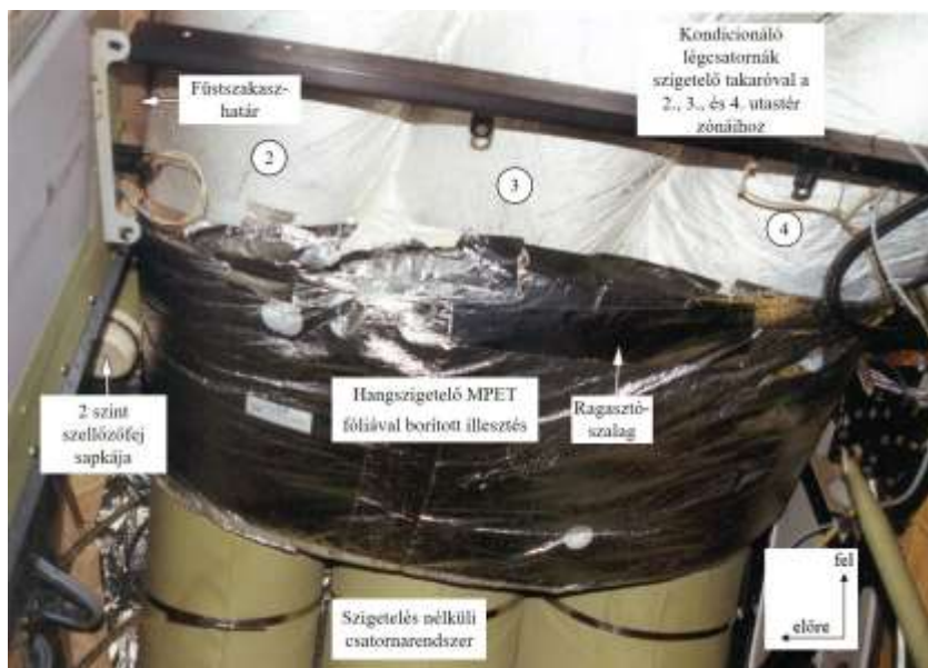
1. ábra: MPET hangszigetelő fóliaborítással fedett illesztés 4
