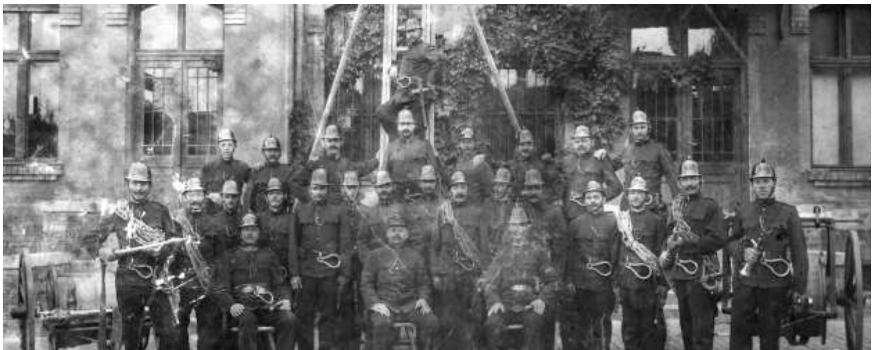
8. fénykép: A scannelt kép közép kivágata. Készítette a szerző.
