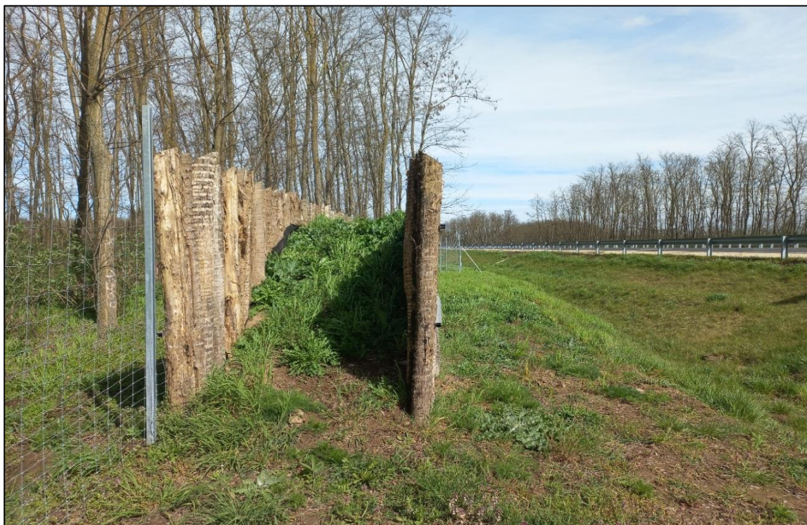
23. kép: Vadkiugró rámpa oldalról a 2x2 sávós 83-as főúton (készítette a szerző)
